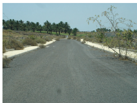
Amplias zonas sin edificar, con falta de mantenimiento de la urbanización.
