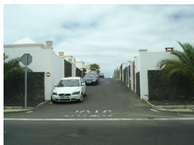
DÉFICIT DE URBANIZACIÓN Inadecuada relación entre espacios públicos y privados. Aceras estrechas y con malos acabados.
